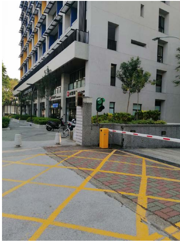
汽機車地下停車場出入口
